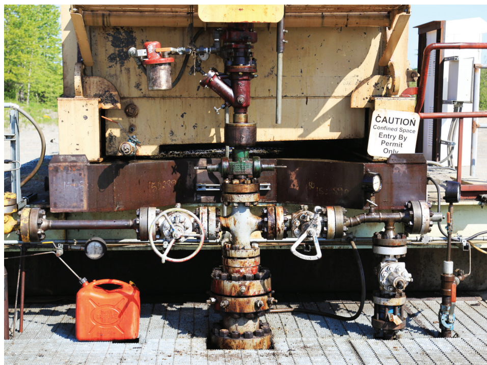
INSTALACJA SZYBU W ZBLIŻENIU, FOT. SEBASTIAN R. BIELAK
