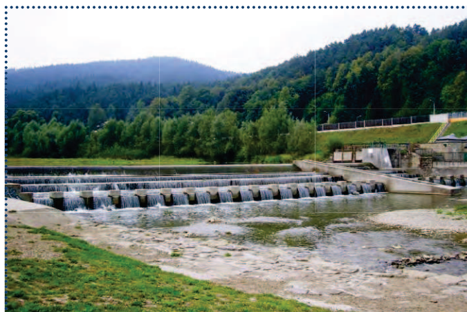
Fot. 8. Kaskada stopni wodnych jako przykład budowli hydrotechnicznych obecnych w korycie Raby, odcinek Myślenice (fot. Jolanta Daniek)
