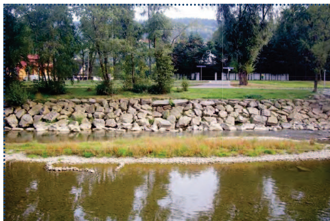
Fot. 9. Narzut kamienny jako jedna z form umocnienia brzegów koryta Raby, odcinek Myślenice (fot. Jolanta Daniek)
